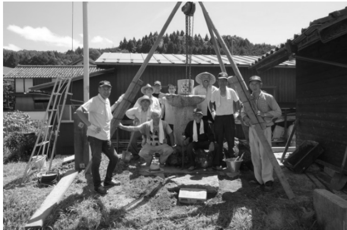
写真4. 住民による移転・修復作業(2)
