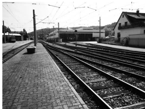
写真 2-6 Ettlingen のトラム車庫
