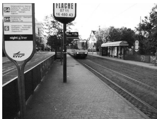
写真 2-1 芝生緑化したトラム専用軌道
