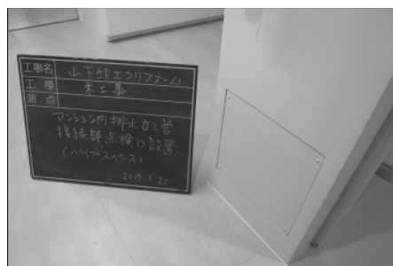
(写真・右上) PS に設置した点検
